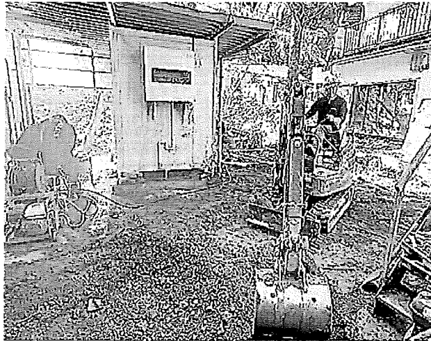
静岡市葵区の土砂災害現場で重機を使って復旧作業に当たる日本笑顔プロジェクトのメンバー（14日撮影、林代表理事提供）
