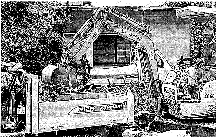
西日本豪雨の被災地で土砂を取り除くメンバー(2018年7月、呉市天応地区で)「コミサポひろしま」提供
